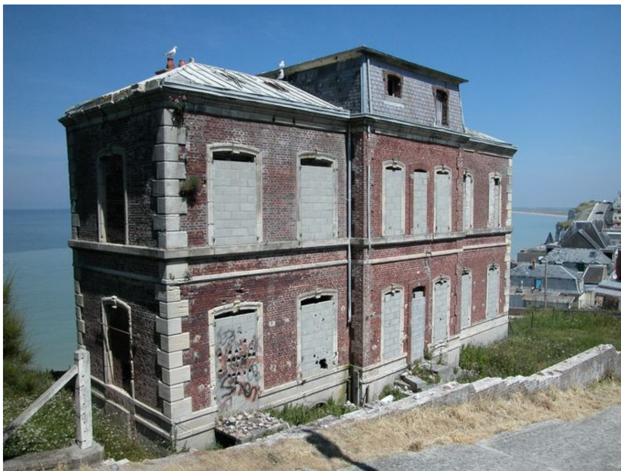
Vue d'ensemble, façade postérieure.
