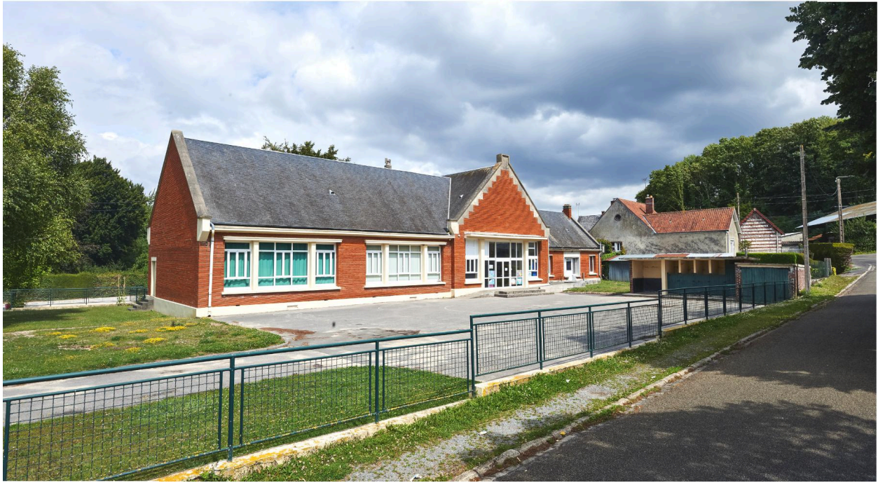
Vue d'ensemble de l'école depuis le sud-ouest.
