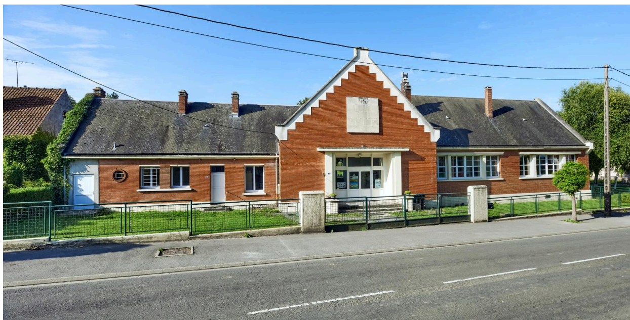
Vue d'ensemble de l'école depuis le nord.
