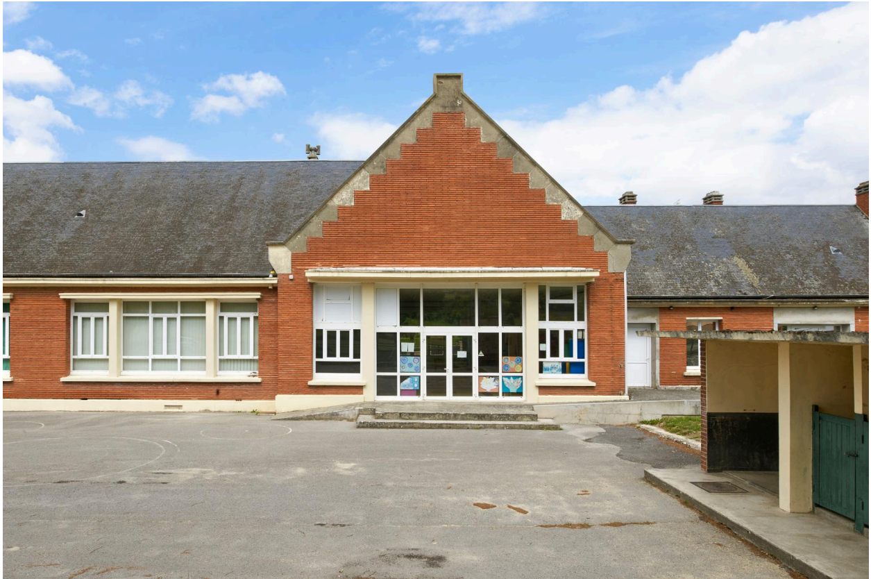
Vue sud de l'entrée de l'école.
