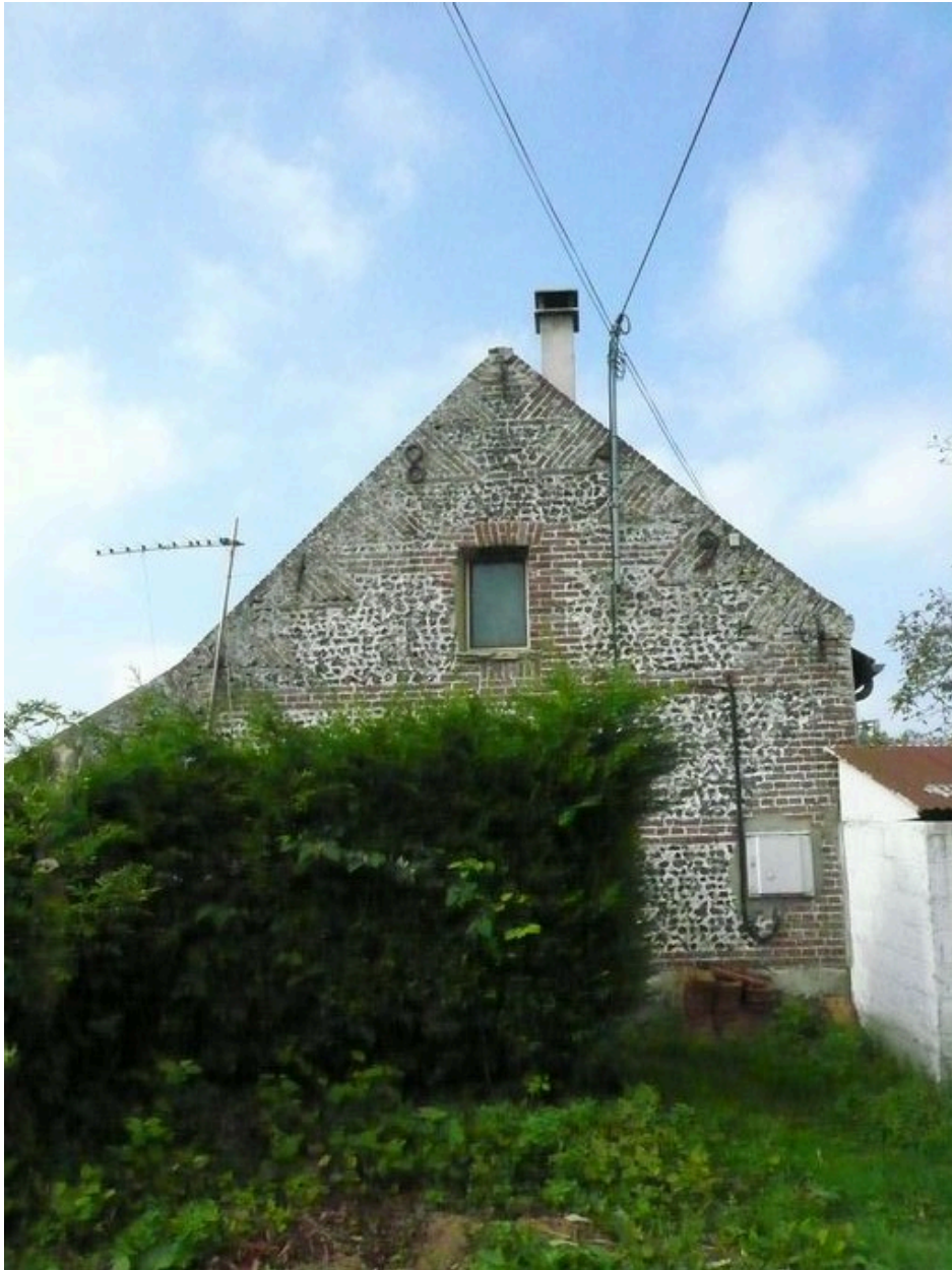
Vue du pignon sur rue, daté de 1849.
