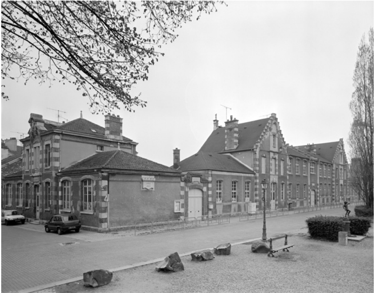
Vue générale depuis la place.
