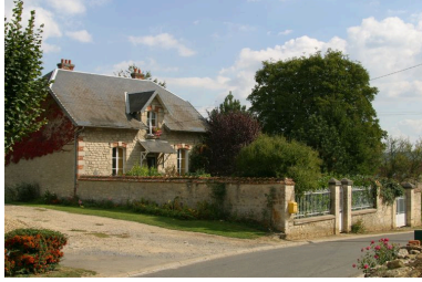
Vue générale. Phot. Inès Guérin IVR22_20030202320NUCA
