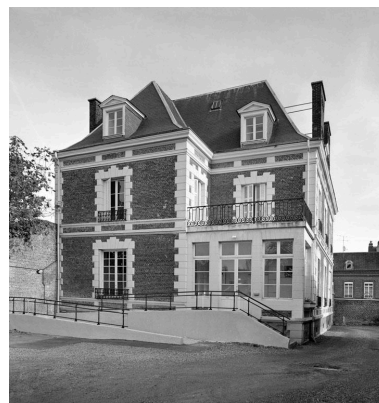
Vue de la façade postérieure sur jardin. Phot. Thierry Lefébure IVR22_20020200849X
