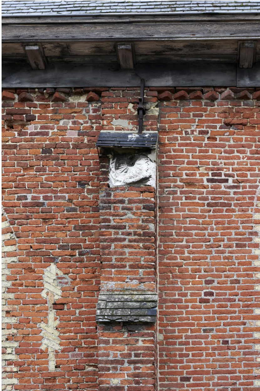
Ancien cadran solaire présent sur le bas-côté sud.
