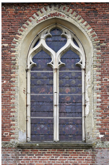
Baie du bas-côté sud. Phot. Delphine Volto Jourdan IVR32_20255900425NUCA
