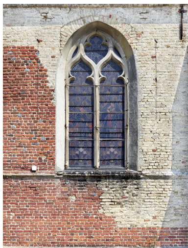
Modification des matériaux lors des reconstructions. Bas-côté sud. Phot. Delphine Volto Jourdan IVR32_20235900741NUCA
