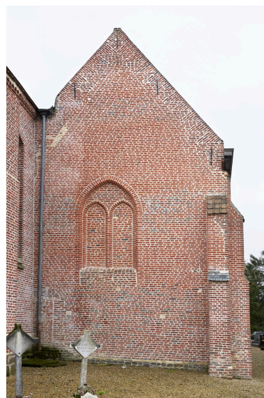
Arrière de l'église. Baie rebouchée du bas-côté nord. Phot. Delphine Volto Jourdan IVR32_20255900426NUCA
