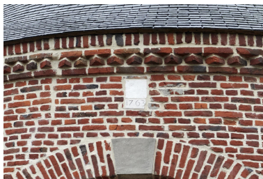
Date portée à l'arrière de l'église "1763". Phot. Delphine Volto Jourdan IVR32_20255900427NUCA
