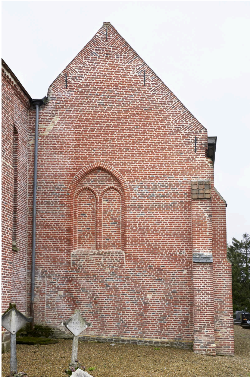
Arrière de l'église. Baie rebouchée du bas-côté nord.
