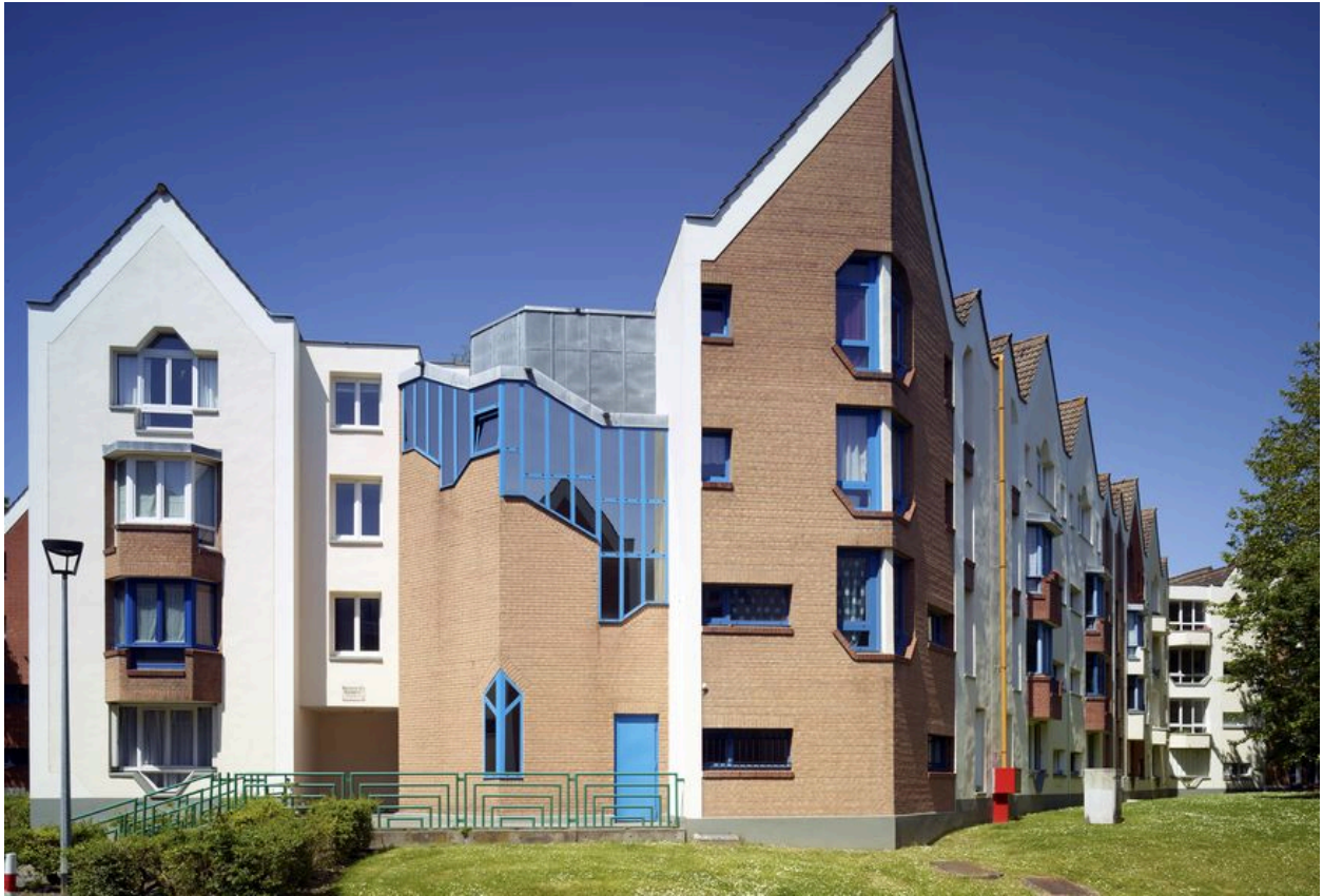
Vue générale de l'immeuble n° 5-7 rue de la Chevalerie, depuis son extrémité sud. Les angles abritent les escaliers desservant les appartements.
