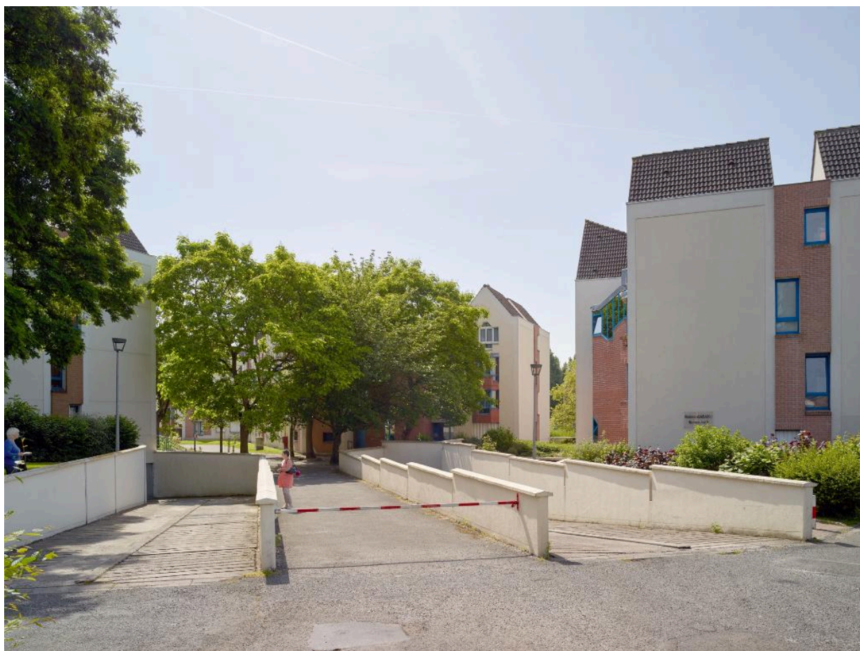
Vue prise depuis la rue de la Chevalerie. Rampes d'accès aux garages souterrains et accès piétonniers au centre de la résidence.
