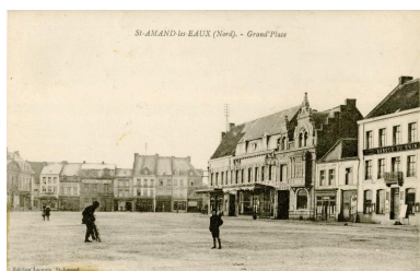
Vue générale de la place, côté ouest vers le sud, 1er (?) quart du 20e siècle après construction de la maison Blauwaert (pignon néo-flamand), carte postale (Musée municipal Saint-Amand-les-Eaux). IVR31_20135908074NUCA
