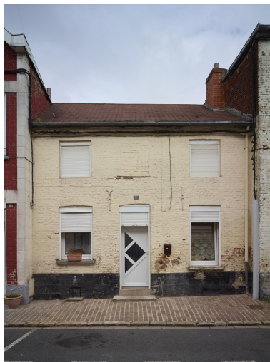
Maison de journalier - 10, rue Baillon. La différence de hauteur par rapport aux maisons voisines est ici bien visible. Phot. Pierre Thibaut IVR32_20245900369NUCA
