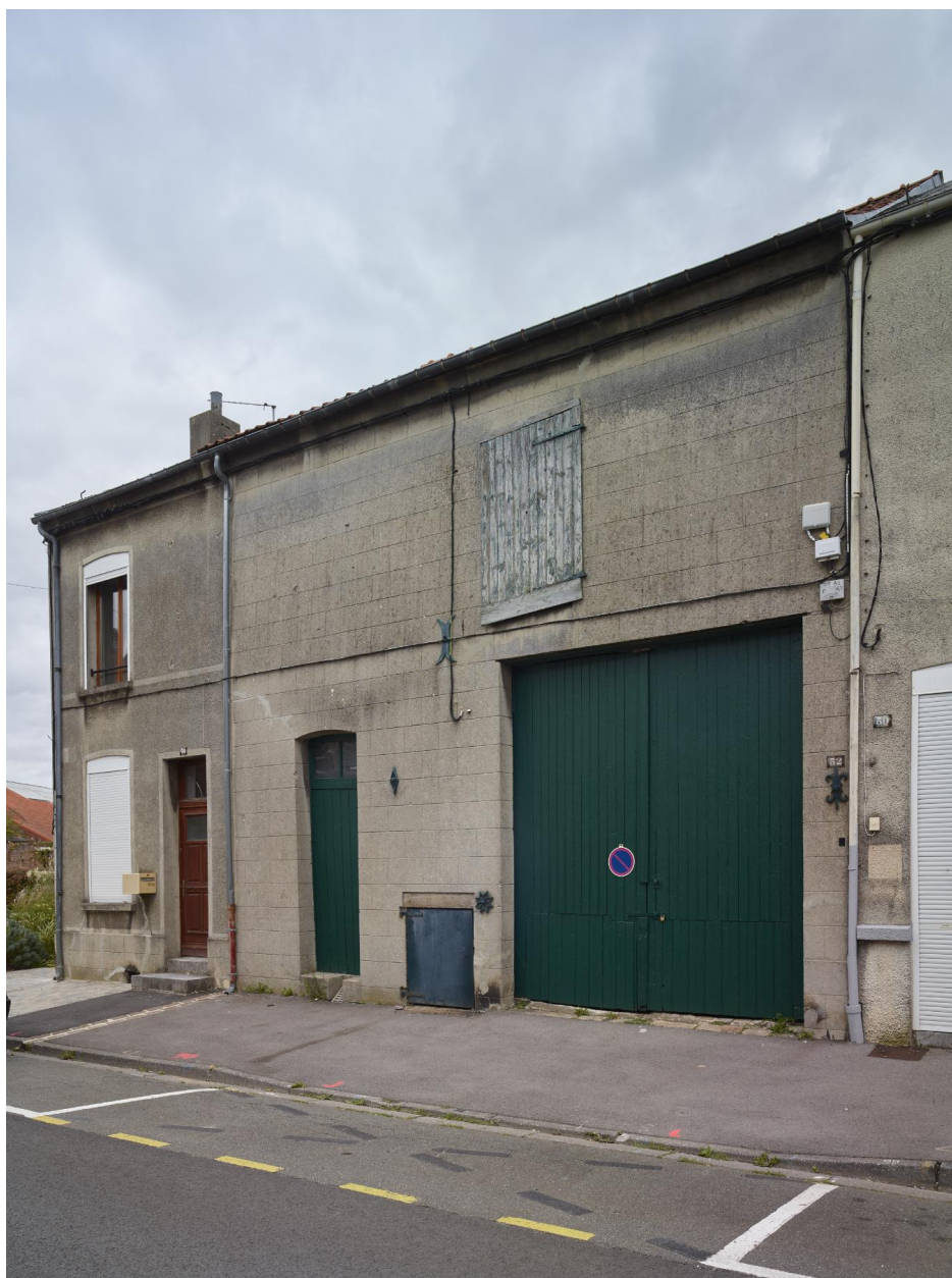
Façades sur la rue Thiers de la porte cochère et de la maison secondaire - 52-54, rue Thiers.
