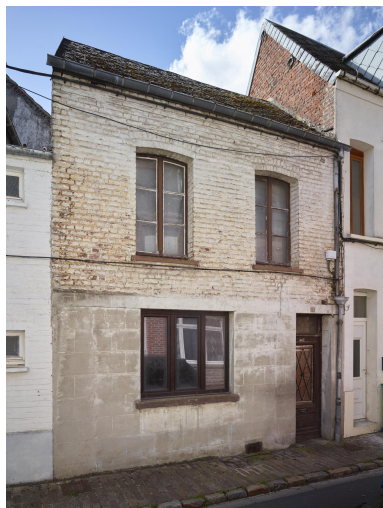
Maison de journalier - 1, rue de Valory. Le rez-de- chaussée a été modifié. Phot. Pierre Thibaut IVR32_20245900762NUCA
