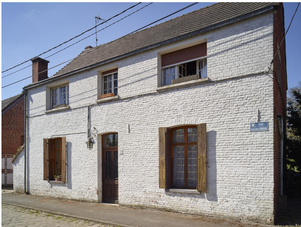
Ferme sur cour - 7, rue Beaudoin-l'Édifieur : vue générale avec le corps de ferme et les bâtiments d'exploitation.
