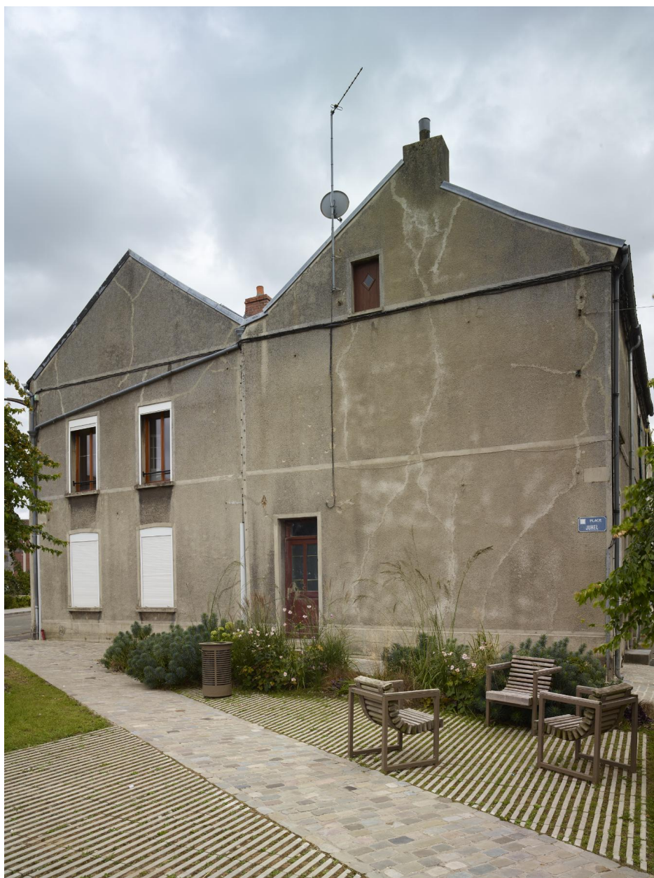
Façades sur la place Juhel de la maison secondaire 54 rue Thiers (façade de droite) et d'une autre maison d'habitation dont l'accès se fait par la rue Thiers. Vue orientée nord-ouest/sud-est.
