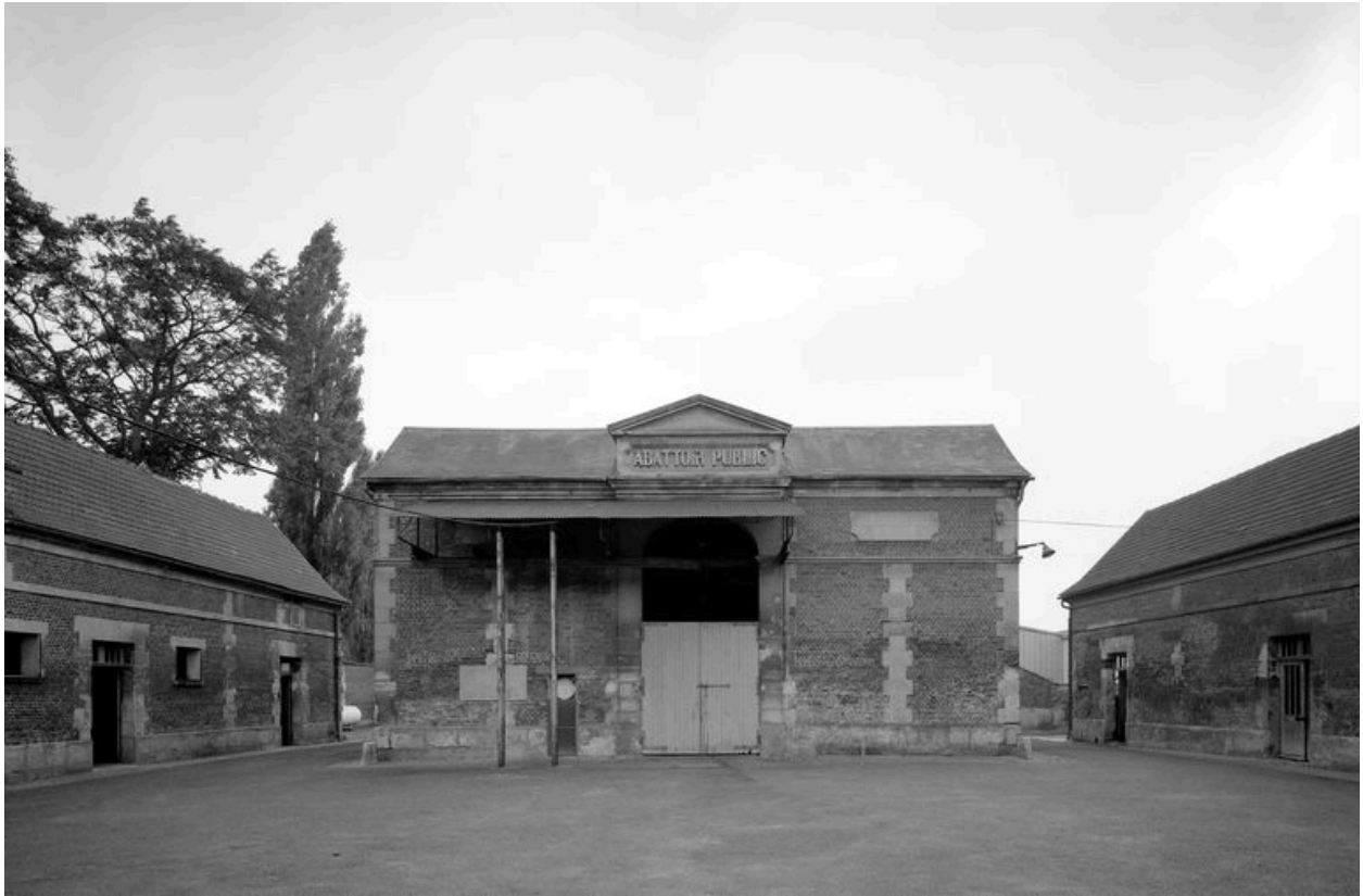
Façade principale de la tuerie et des bouveries.
