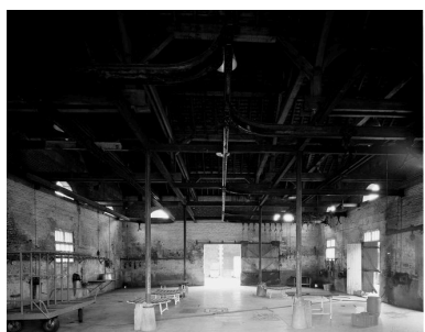
Tuerie : vue intérieure. Phot. Fabrice Charrondière IVR22_19856001437V
