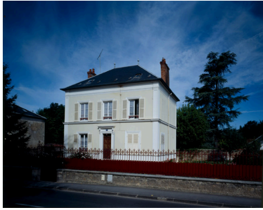
Vue d'ensemble depuis la rue. Phot. Thierry Lefébure IVR22_19930200951VA
