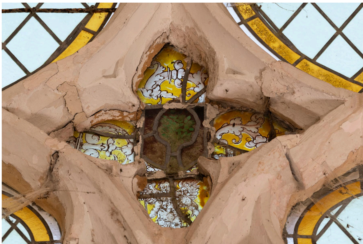
Fragments de vitrail dans les jours de réseau (baie 5) : rinceaux végétaux, XVIe siècle.
