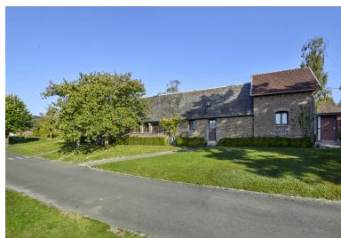
Vue d'une des dépendances, depuis le sud. Phot. Thierry Lefébure IVR32_20258001447NUCA
