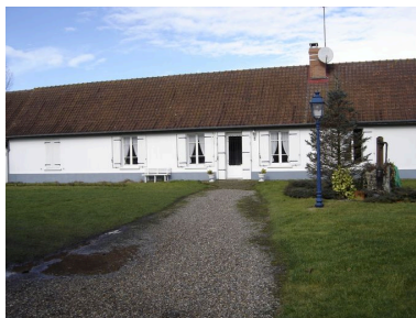
Vue du logis en fond de cour. Phot. Inès Guérin IVR22_20058005088NUCA
