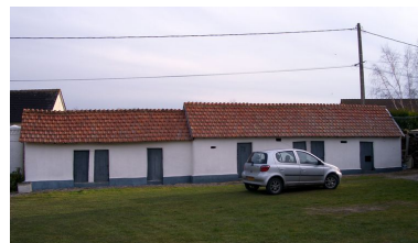
Vue des étables à cochons depuis la cour. Phot. Inès Guérin IVR22_20058005090NUCA
