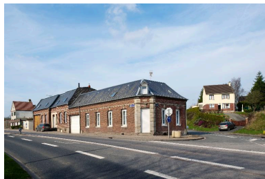
Vue d'ensemble. Phot. Thierry Lefébure IVR22_20138000108NUC2A
