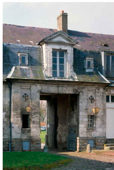
Portail d'entrée : élévation est. Phot. Irwin Leullier IVR22_19998000585XA
