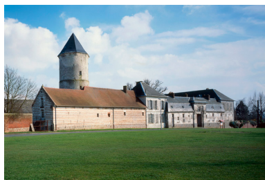
Vue générale depuis le nord : élévations donnant sur la place des Déportés. Phot. Irwin Leullier IVR22_19998000580XA
