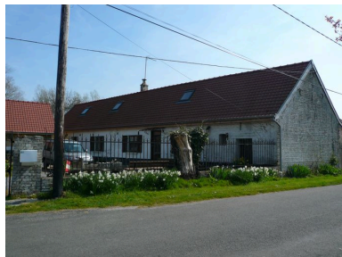
Vue du logis. Phot. Inès Guérin IVR22_20078005910NUCA
