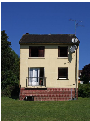
Façade sur jardin d'un logement. Phot. Bertrand Fournier IVR22_20098005104NUCA
