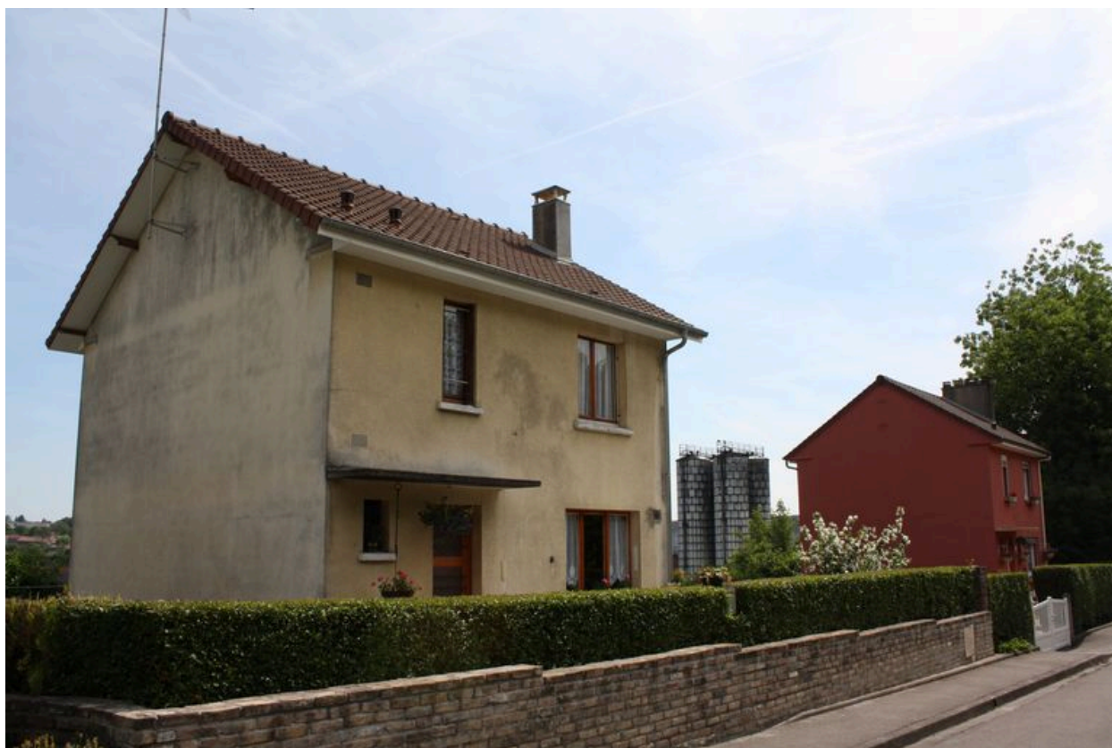
Vue de deux des six maisons de cadre.
