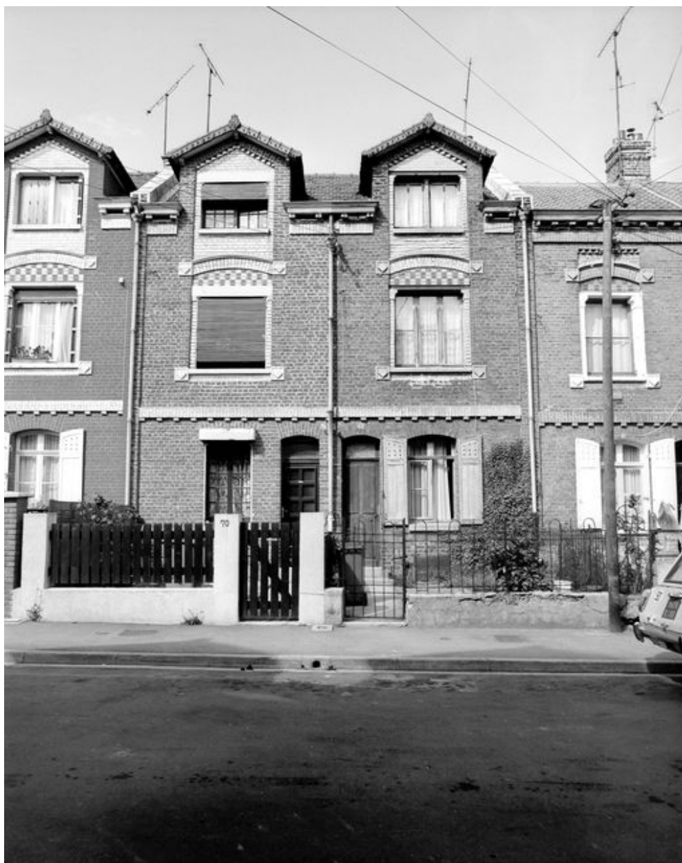
Détail de logements d'ouvriers.
