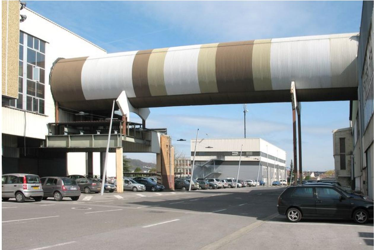
Une partie du tunnel de passage (long de 140 mètres) des fonds de caisses reliant la chaîne de préparation à gauche (dégraissage, trempé, égouttage, rinçage, cuisson) à l'atelier de mécanique.
