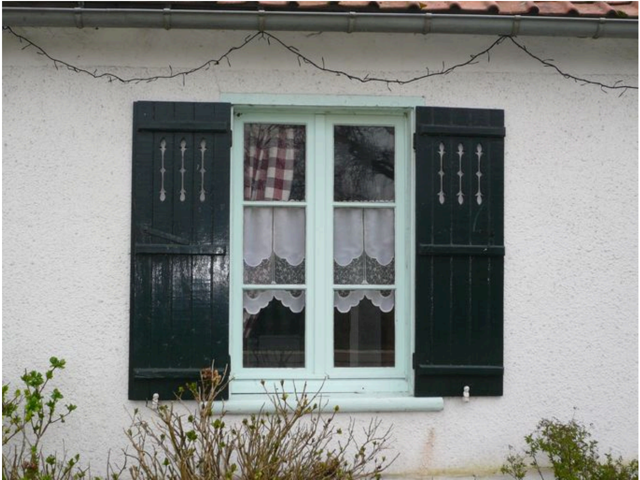
Vue détaillée d'un des contrevents.
