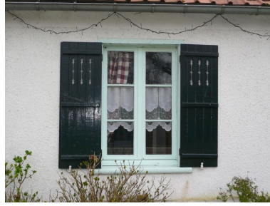
Vue détaillée d'un des contrevents. Phot. Inès Guérin IVR22_20078005465NUCA
