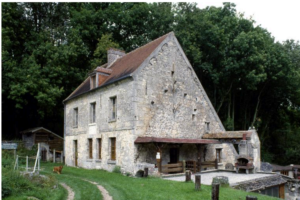
Vue du moulin depuis le sud-ouest.
