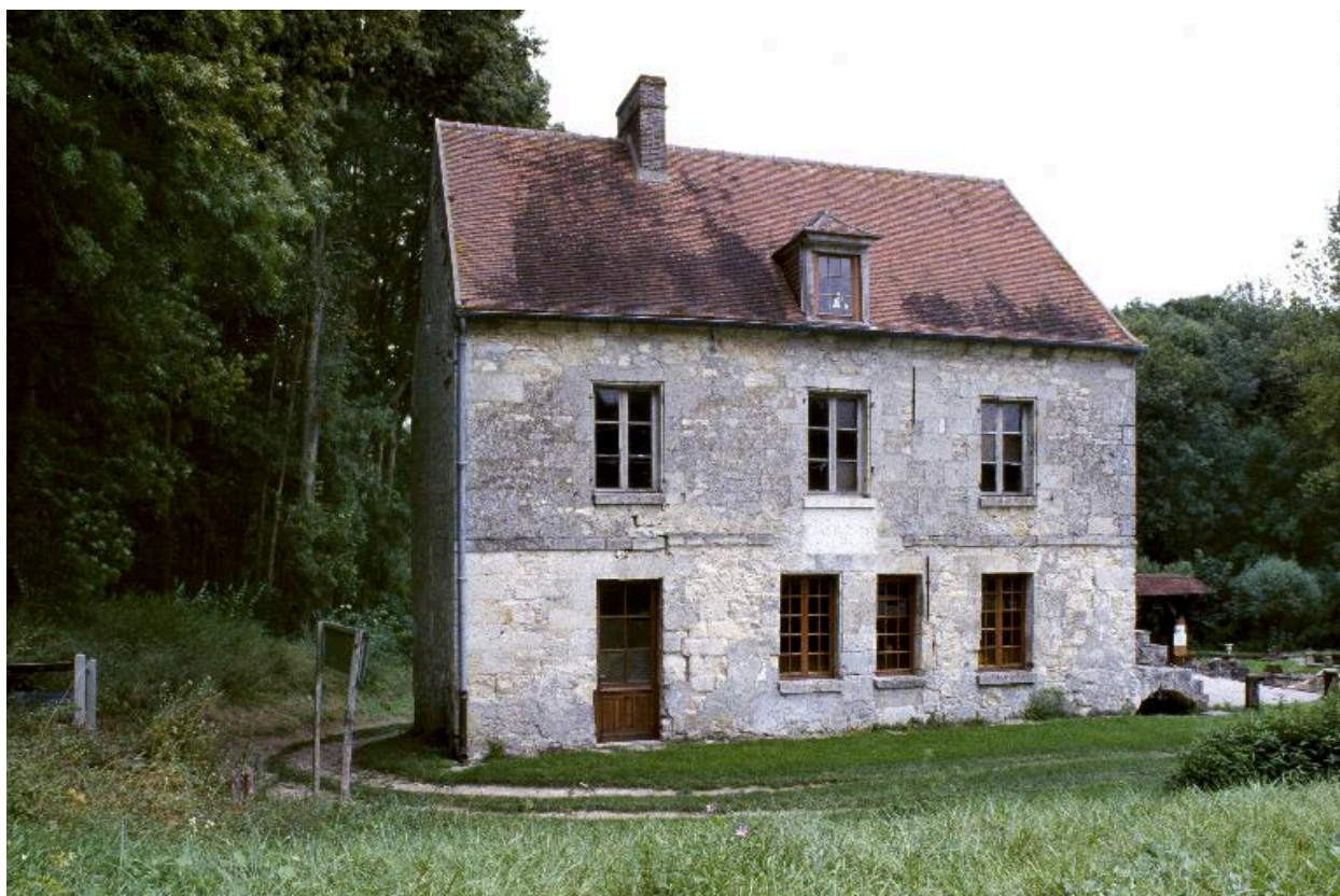
Vue de l'élévation occidentale du moulin.
