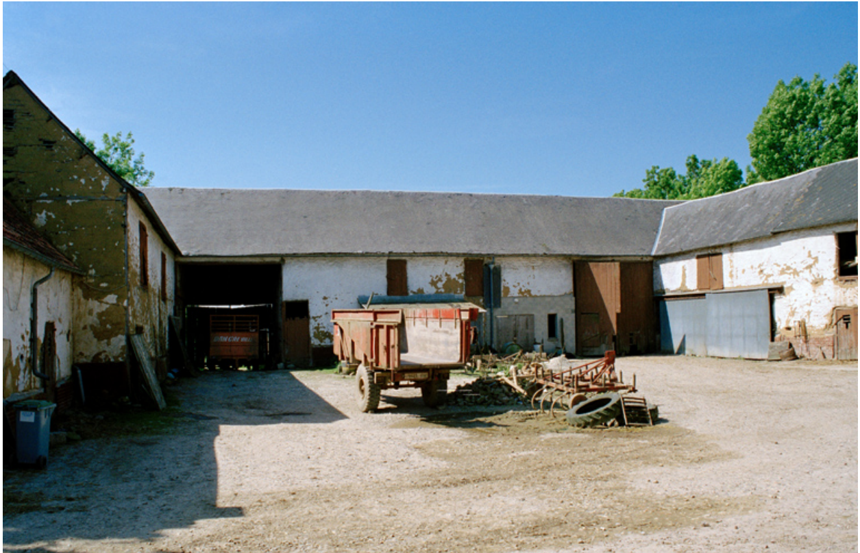
Vue du côté sud de la ferme : la grange.
