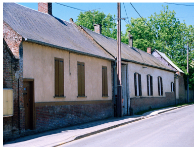
Elévation sur rue du logis. Phot. Judith Förstel IVR22_20018000130ZE
