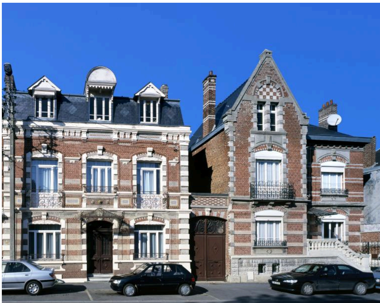
Vue de situation, maison à gauche de l'image.
