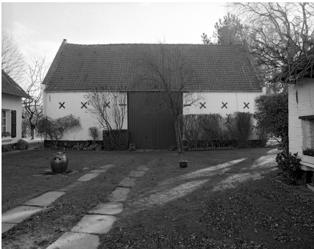
Vue générale avant restauration.
