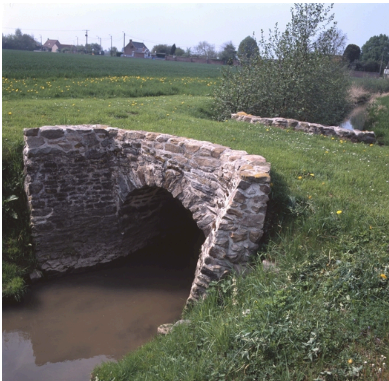
Vue générale du ponceau après restauration.
