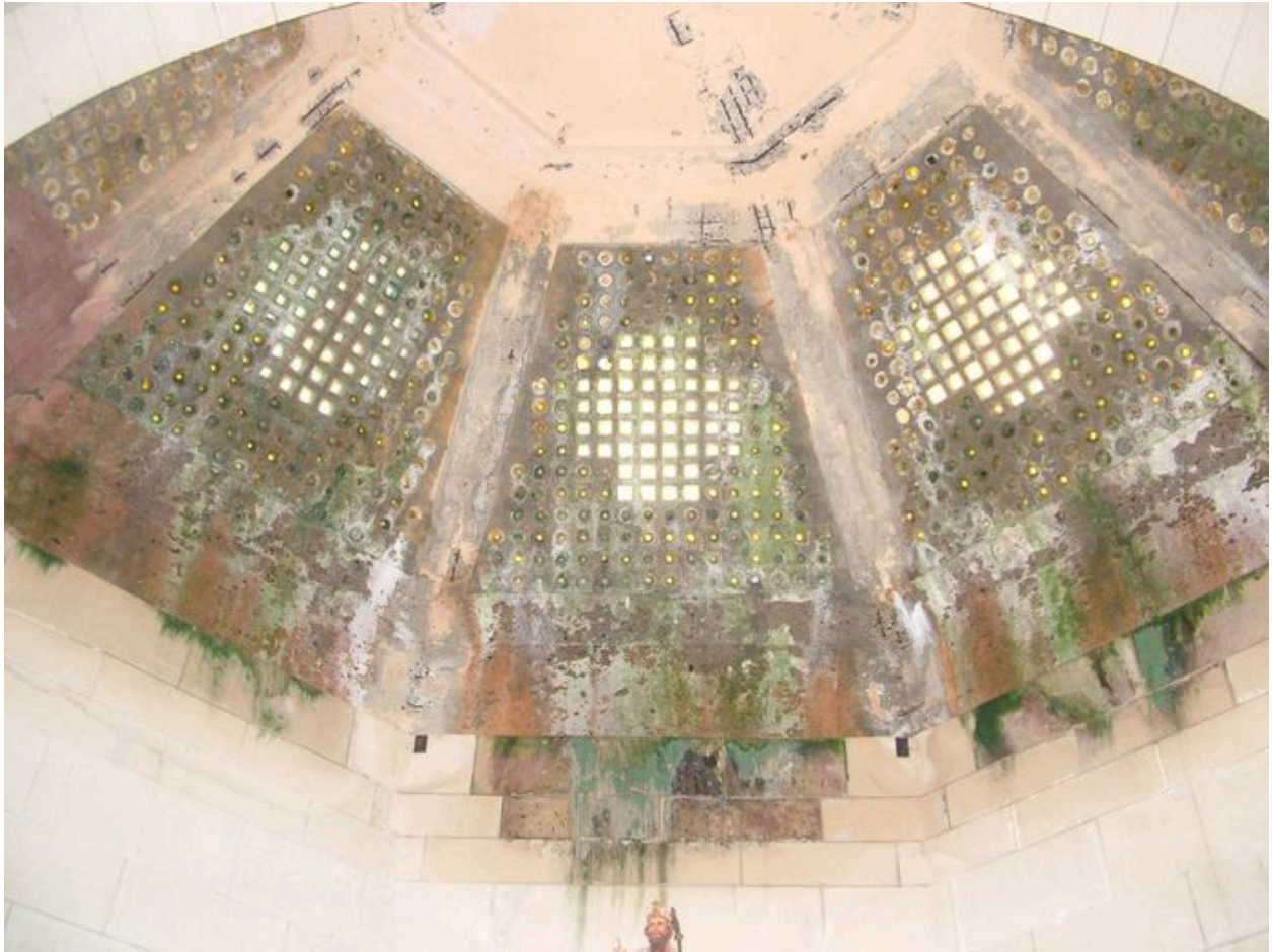
Vue de la dalle de verre présente dans l'abside.
