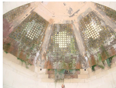
Vue de la dalle de verre présente dans l'abside. Phot. Inès Guérin IVR22_20050200322NUCA
