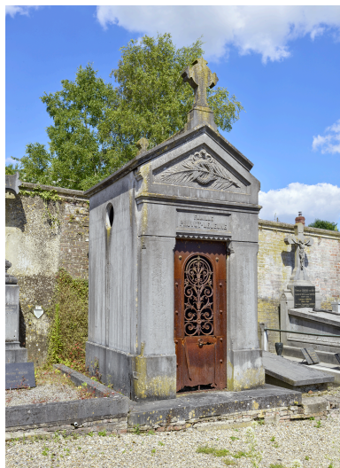
Chapelle de la famille Pruvot- Lejeune, au nord du cimetière. Phot. Thierry Lefébure IVR32_20258000465NUCA
