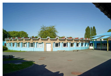
Bâtiment abritant la bibliothèque et la salle de travail des élèves, à l'ouest (vue depuis la cour). Phot. Pierre Thibaut IVR32_20175900872NUCA
