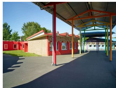
Le préau parcourt la cour du collège et desservant les différents bâtiments. Phot. Pierre Thibaut IVR32_20175900871NUCA
