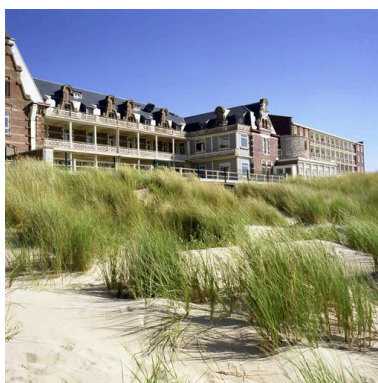
Bâtiment méridional de l'établissement primitif, élévation sur la plage, vue de trois-quarts gauche. Phot. Pierre Thibaut IVR31_20096200005XE
