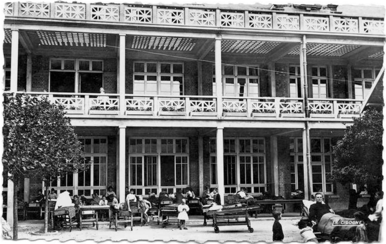
Bâtiment d'hospitalisation ajouté dans l'entre-deux-guerres au nord de l'établissement, élévation sur la cour avec ses galeries de cure d'air superposées. Carte postale, milieu du 20e siècle (coll. part.).
