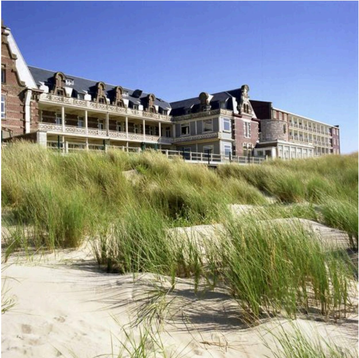
Bâtiment méridional de l'établissement primitif, élévation sur la plage, vue de trois-quarts gauche.
