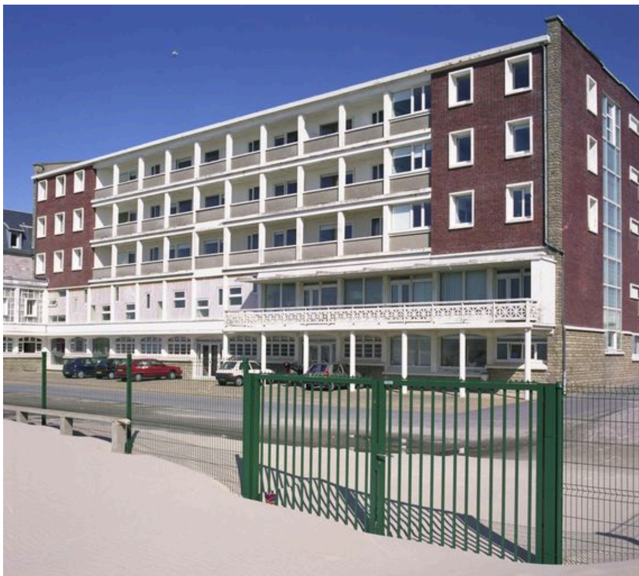
Nouveau bâtiment d'hospitalisation ajouté dans les années 1960 sur le flanc sud de la chapelle, élévation antérieure donnant sur la plage, vue de trois-quarts droit.
