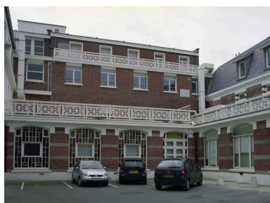
Cour qui s'étend sur l'arrière du bâtiment méridional de l'établissement primitif, vue générale. Phot. Pierre Thibaut IVR31_20086200017XE
