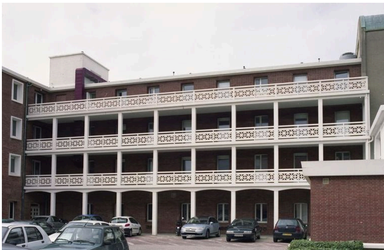
Nouveau bâtiment d'hospitalisation ajouté dans les années 1960 sur le flanc sud de la chapelle, élévation postérieure, vue de trois-quarts droit.
