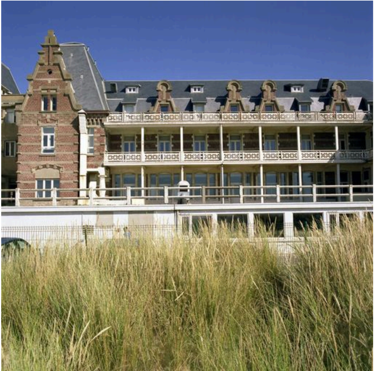
Bâtiment méridional de l'établissement primitif, élévation sur la plage.
