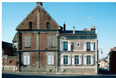
Elévation antérieure. Pignon. Phot. Martine Plouvier IVR22_19856001334ZA
