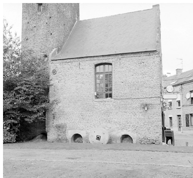
Vue de la façade autrefois baignée par la Haynette ; la troisième roue se trouvait au bas de la tour ; état en 2005.
