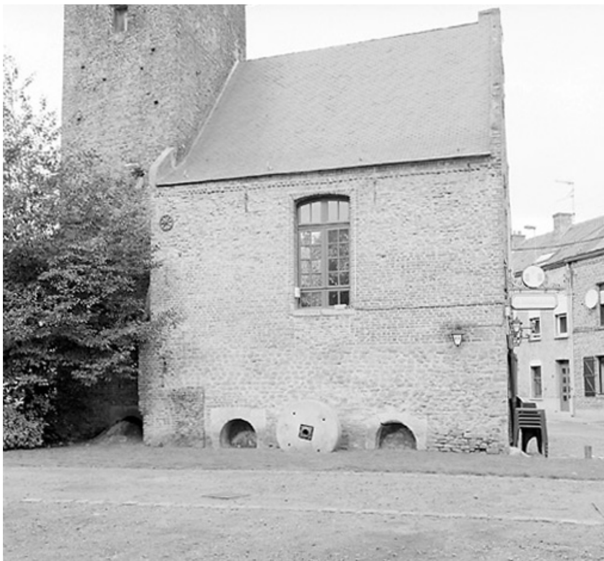
Vue de la façade autrefois baignée par la Haynette ; la troisième roue se trouvait au bas de la tour ; état en 2005.
