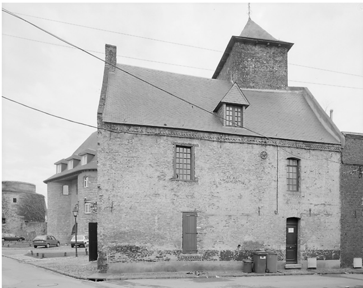
Vue de la façade rue du Munitionnaire, état en 2001.
