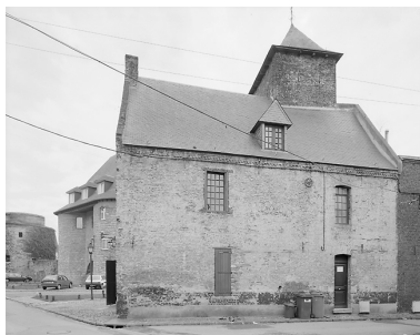
Vue de la façade rue du Munitionnaire, état en 2001.
