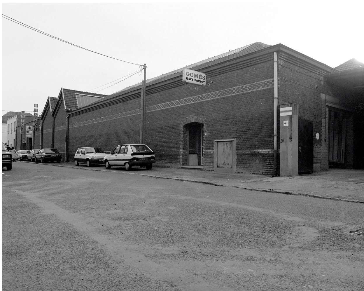
Élévation rue Voltaire, vers le sud.
