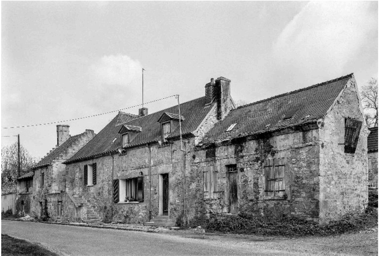
Anciens bâtiments de ferme (25 Grande rue) : élévation sud-ouest, sur rue.
