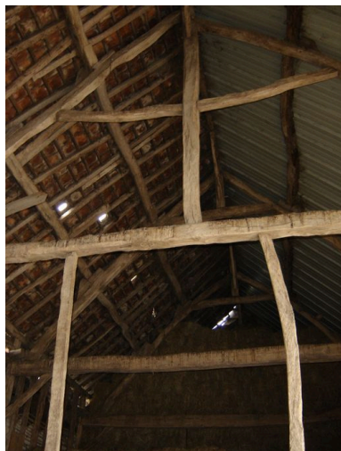
Détail de la charpente de la grange. Phot. Inès Guérin IVR22_20058005120NUCA
