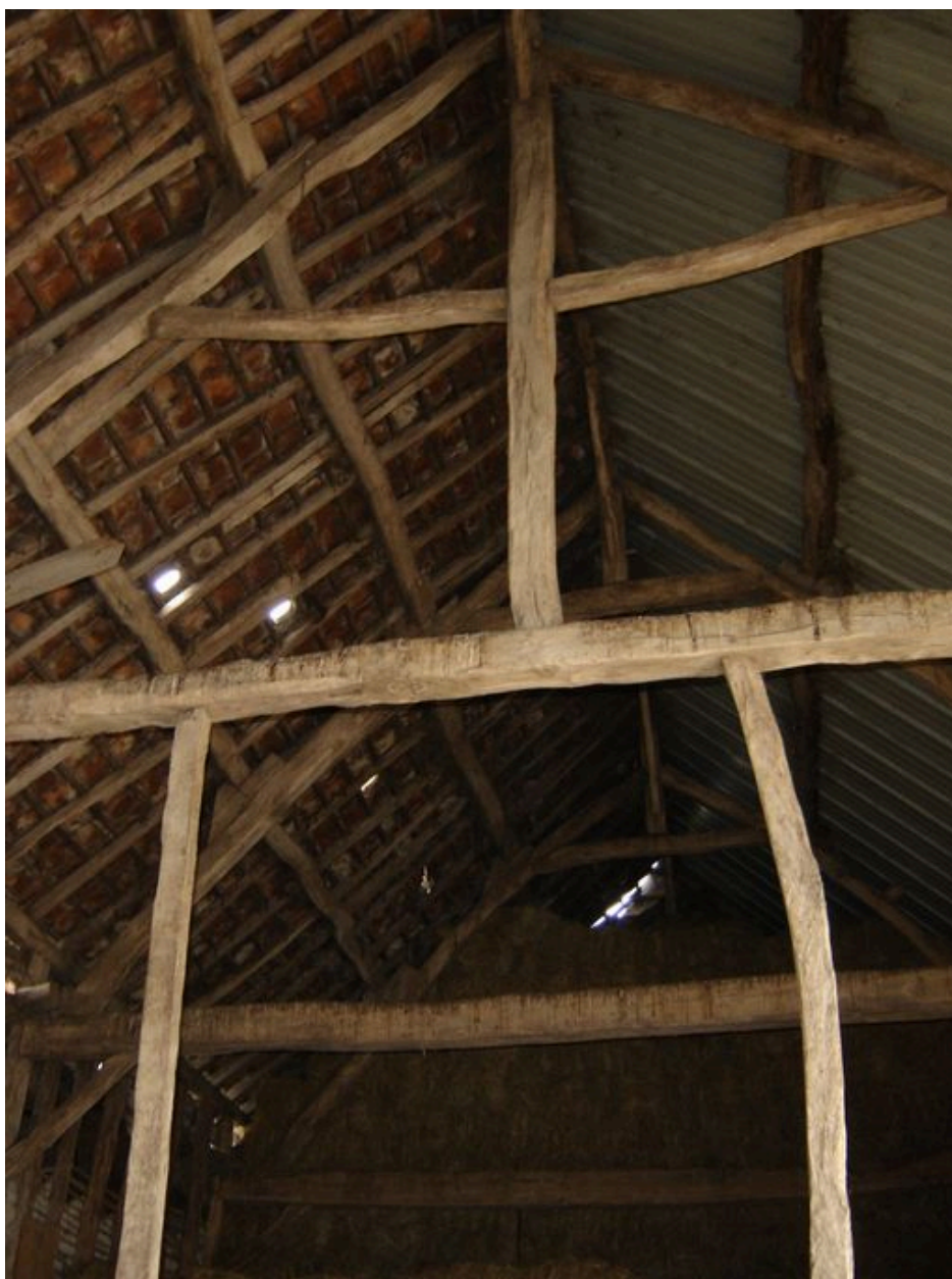
Détail de la charpente de la grange.
