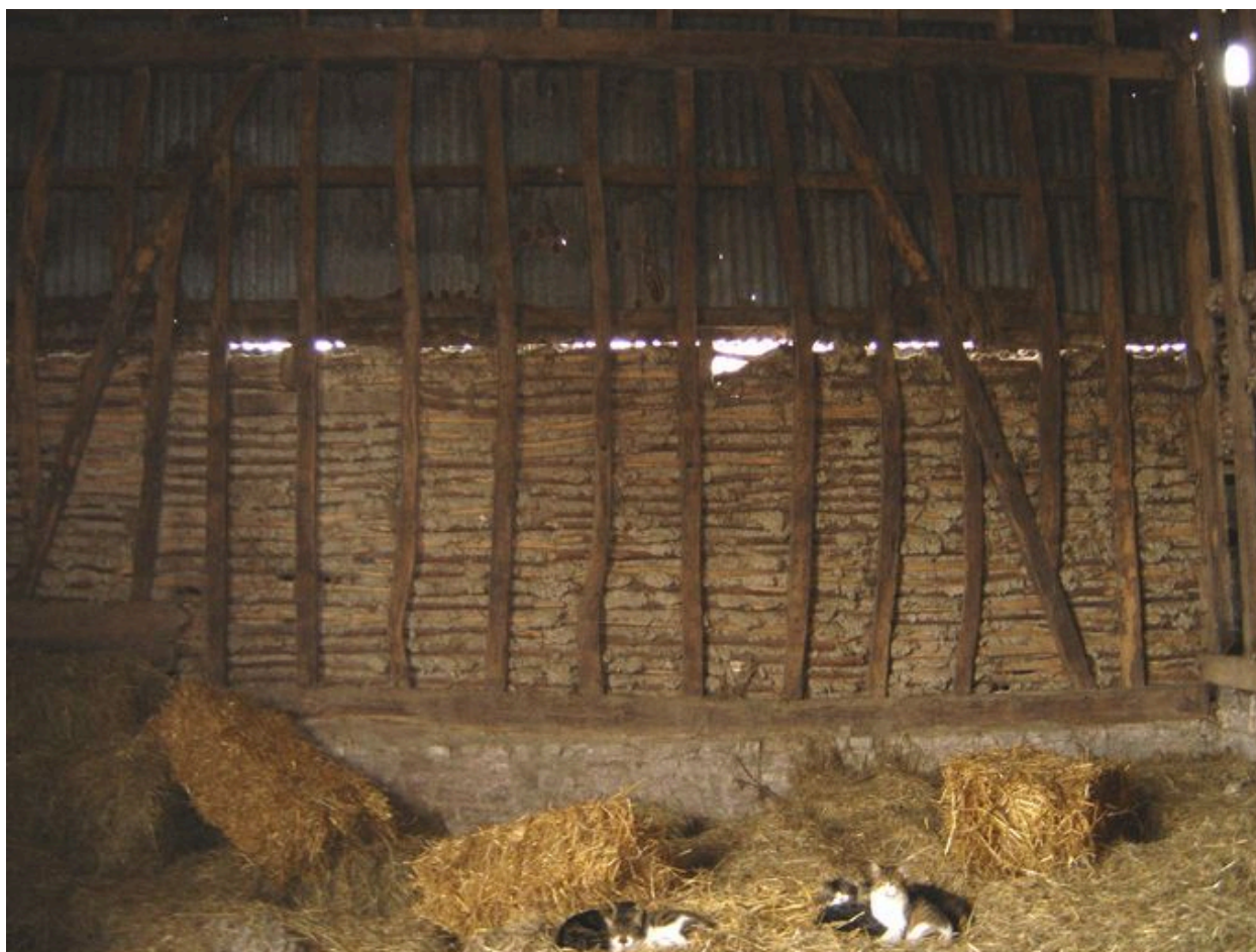
Vue intérieure de la grange.
