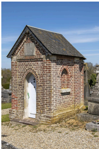
Tombeau en forme de chapelle de la famille Aubry- Huchez, 1883 (date portée). Phot. Marc Kérignard IVR32_20216000346NUCA
