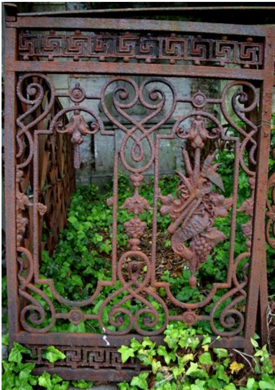
Vantail gauche de la grille de clôture.
