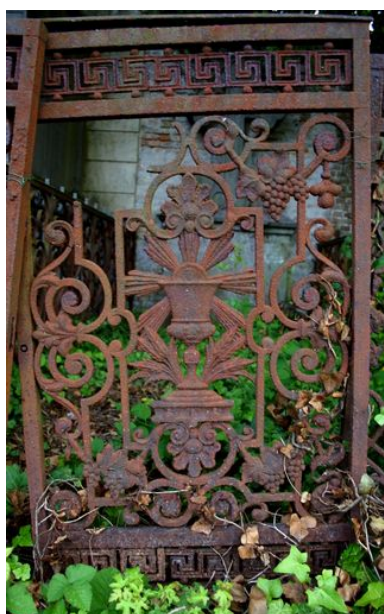
Vantail central de la grille de clôture.
