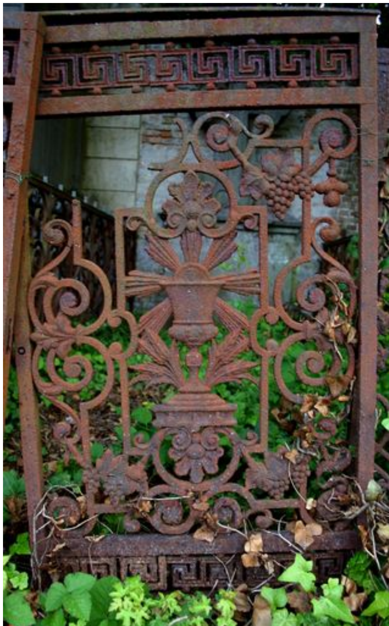
Vantail central de la grille de clôture.
