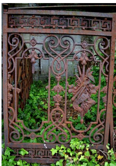
Vantail gauche de la grille de clôture.
