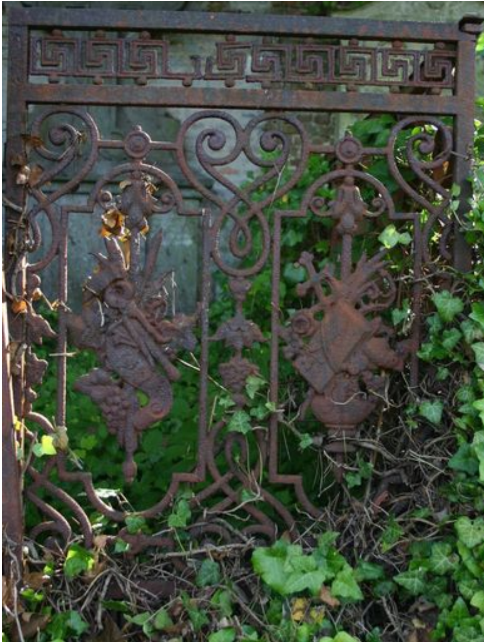
Vantail droit de la grille de clôture.
