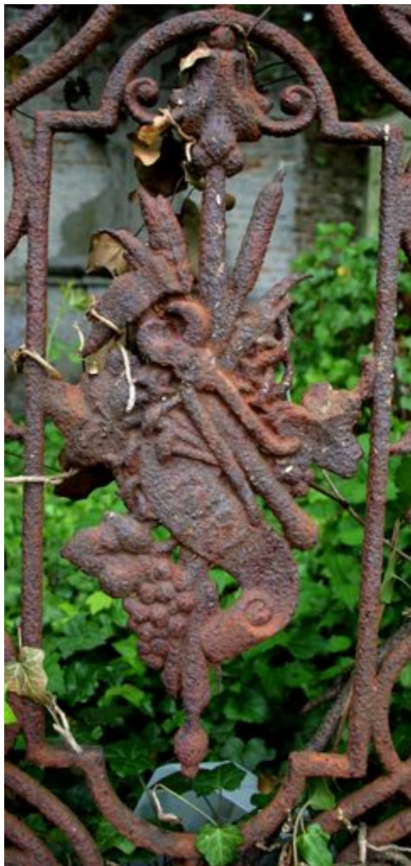
Détail du décor du vantail droit de la grille de clôture.
