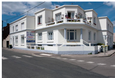
Vue générale. Phot. Pierre Thibaut IVR31_20146202186NUCA
