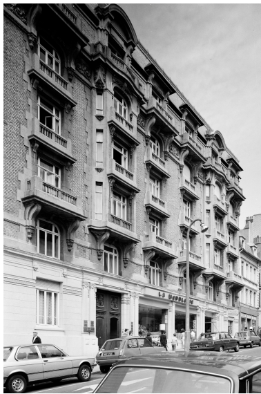
Vue générale d'angle sur voie. Phot. Philippe Caudroit, Phot. Éric Dessert IVR31_19806204523X
