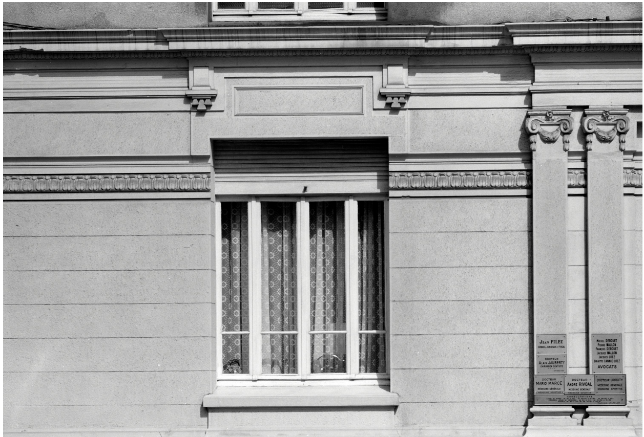
Façade sur voie, rez-de-chaussée, fenêtre.
