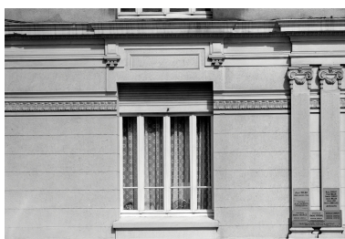
Façade sur voie, rez- de-chaussée, fenêtre. Phot. Philippe Caudroit, Phot. Éric Dessert IVR31_19806205180X
