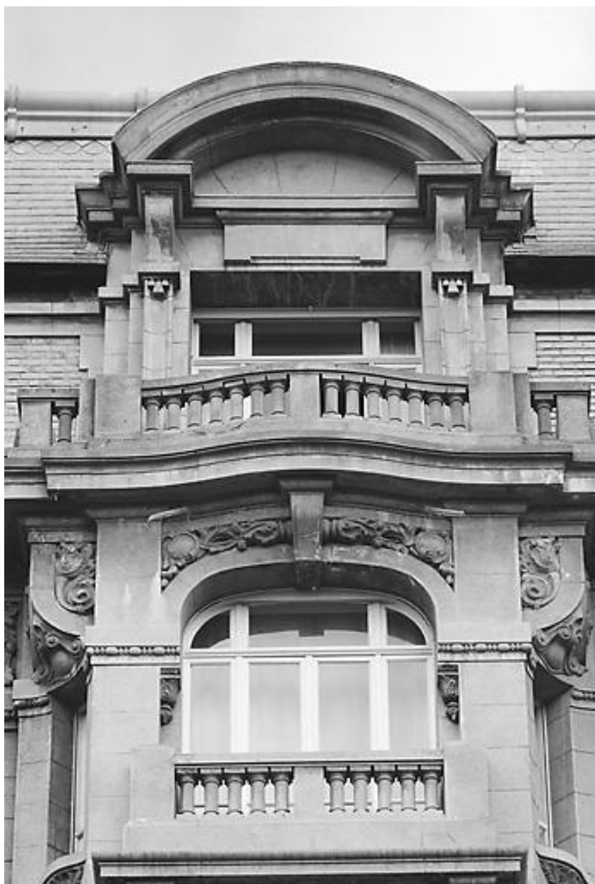
Façade sur voie, 4e étage, étage de comble, lucarne en arc segmenté, baie.
