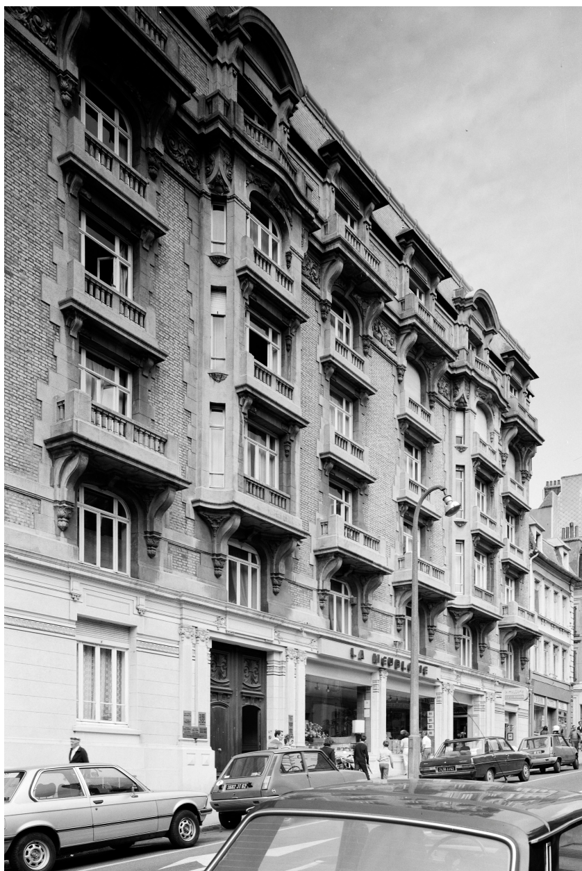
Vue générale d'angle sur voie.
