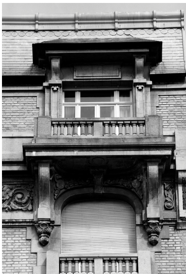
Façade sur voie, 4e étage, étage de comble, lucarne, baie. Phot. Philippe Caudroit, Phot. Éric Dessert IVR31_19806205176X
