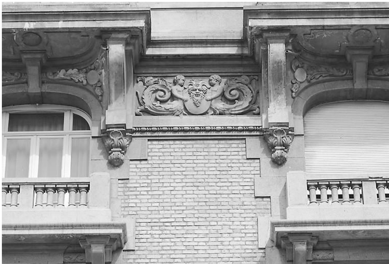
Façade sur voie, 4e étage, bas relief.
