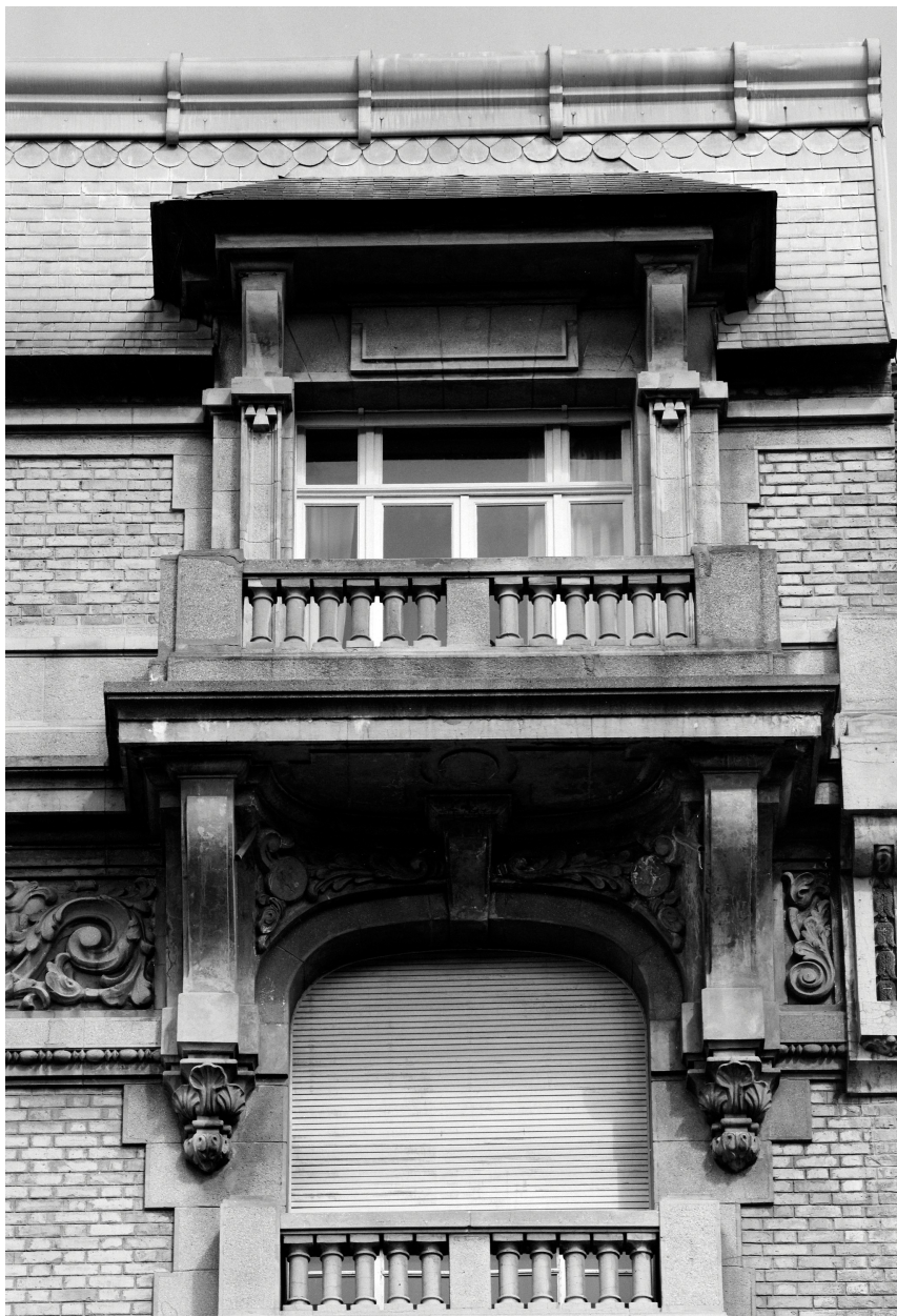
Façade sur voie, 4e étage, étage de comble, lucarne, baie.
