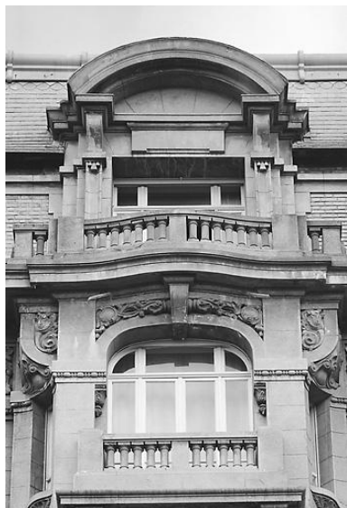
Façade sur voie, 4e étage, étage de comble, lucarne en arc segmenté, baie. Phot. Philippe Caudroit, Phot. Éric Dessert IVR31_19806205177X
