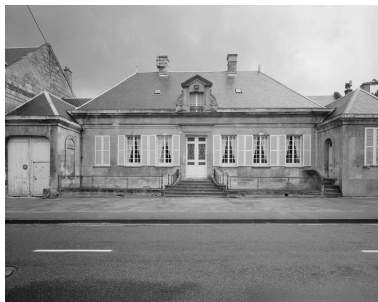
Elévation antérieure. Phot. Jean-Michel Périn IVR22_19856000821V
