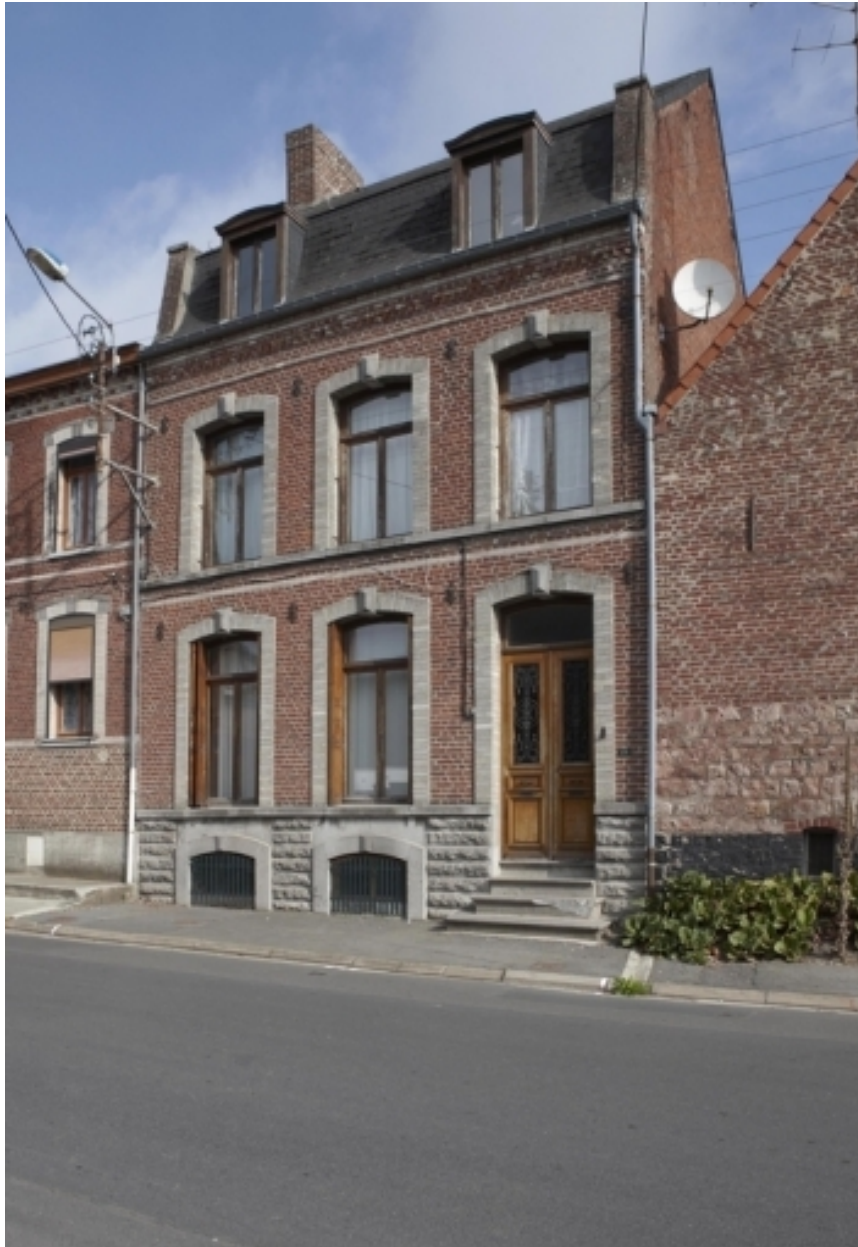
Vue générale de la maison située 103 rue Barbeau.
