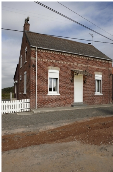
Vue générale de la maison située 1424 rue du Sarloton. Phot. Pierre Thibaut IVR31_20095903244NUCA
