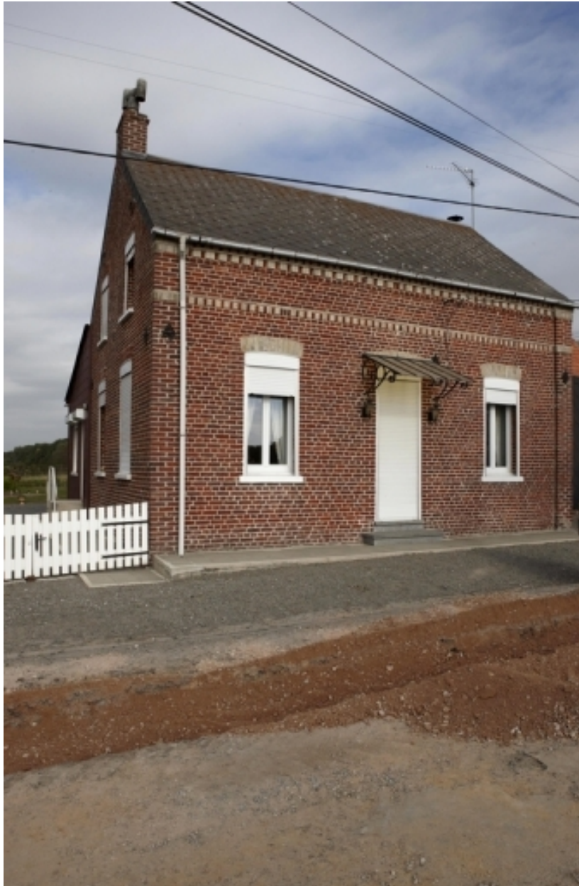
Vue générale de la maison située 1424 rue du Sarloton.
