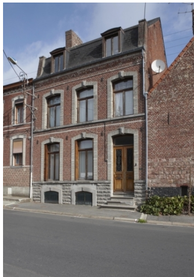
Vue générale de la maison située 103 rue Barbeau. Phot. Pierre Thibaut IVR31_20095903267NUCA
