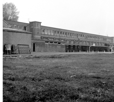
Élévation postérieure. Vue prise depuis le sud-est. Phot. Philippe Dapvril IVR31_19885900733X
