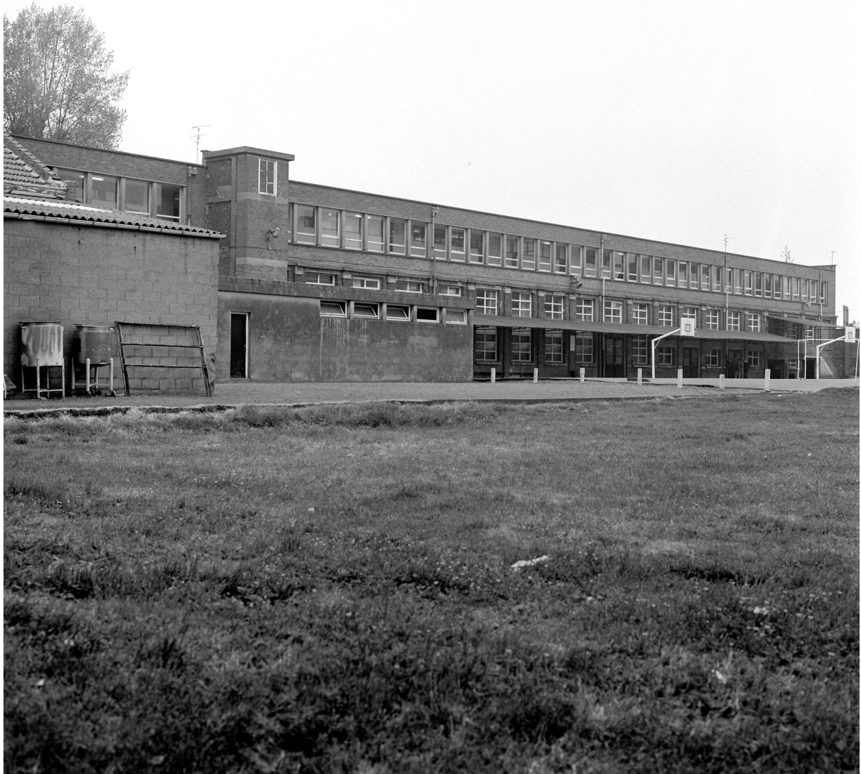
Élévation postérieure. Vue prise depuis le sud-est.
