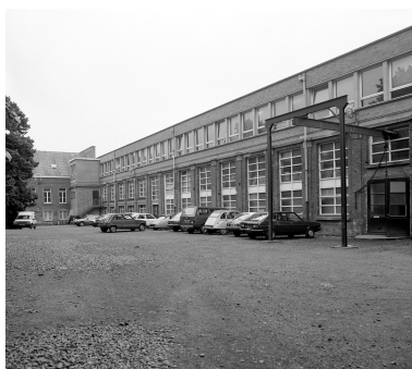
Élévation antérieure sur cour. Vue prise depuis l'ouest. Phot. Philippe Dapvril IVR31_19885900731X
