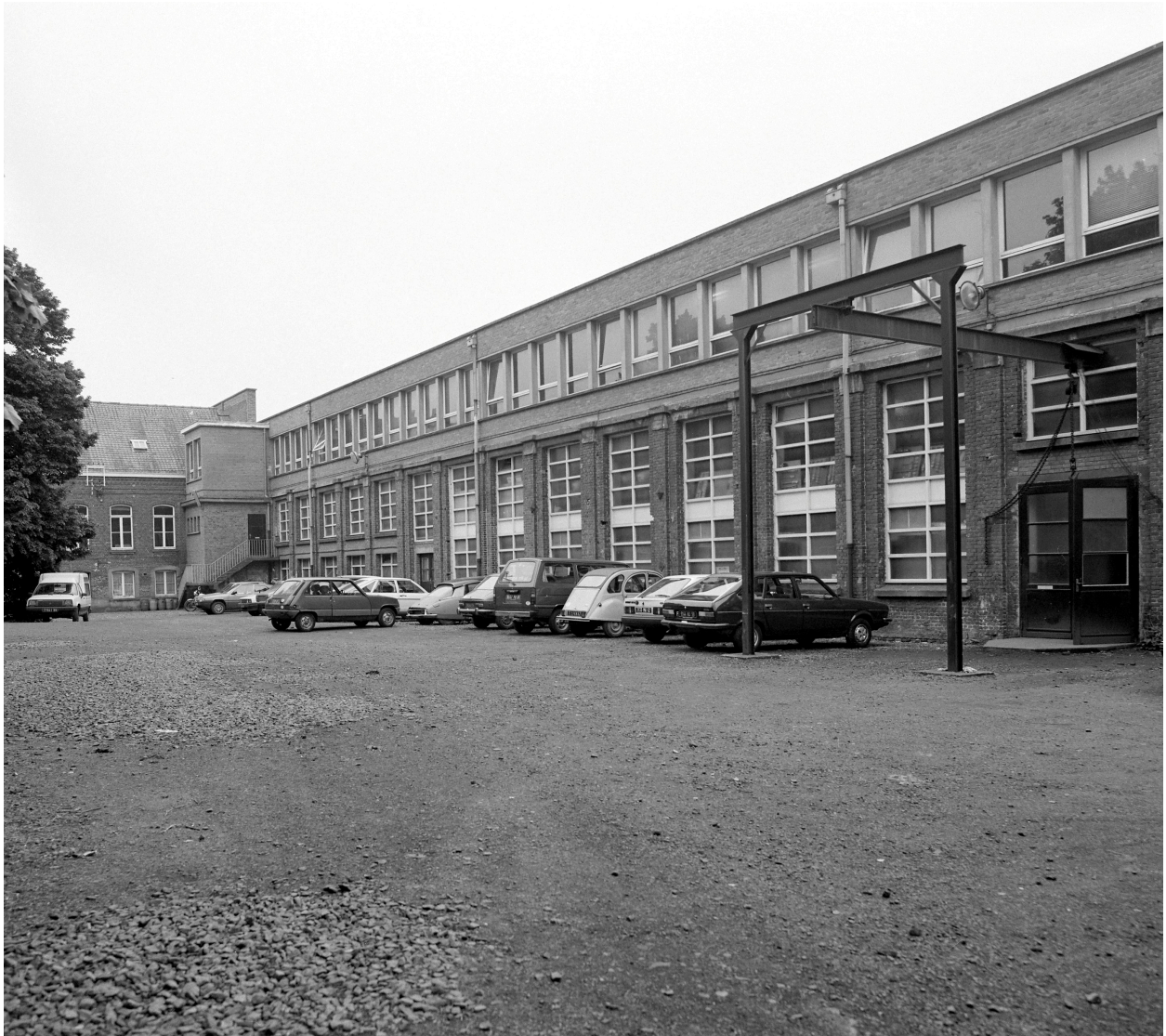
Élévation antérieure sur cour. Vue prise depuis l'ouest.
