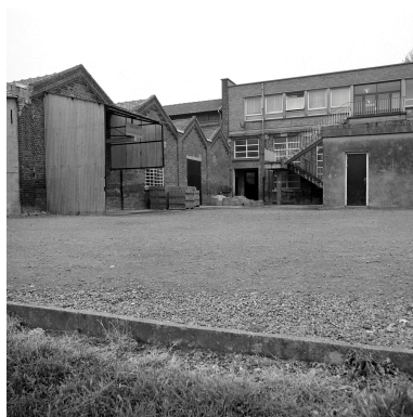
Entrepôts industriels depuis la cour. Vue prise vers le nord-ouest. Phot. Philippe Dapvril IVR31_19885900734X
