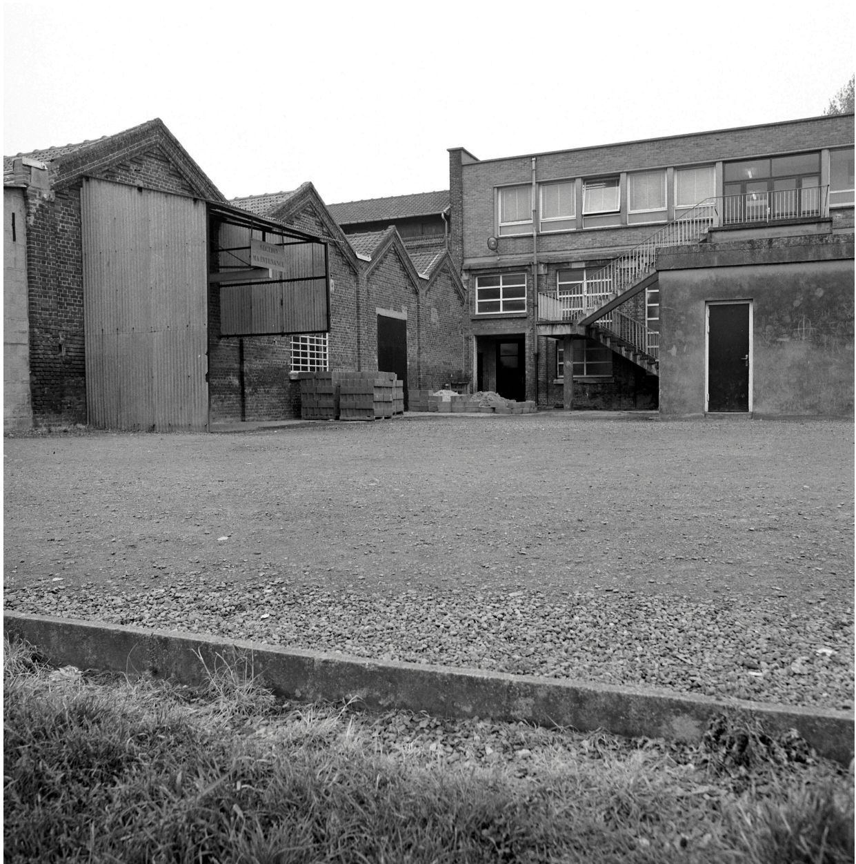
Entrepôts industriels depuis la cour. Vue prise vers le nord-ouest.
