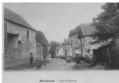
Havernas - Rue d'Amiens, début 20e siècle (coll. part.). Le passage charretier de la grange, à gauche de l'image.
