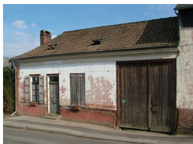
Logis et passage charretier. Phot. Frédéric Fournis IVR22_20108001119NUCA
