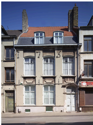
Vue générale de la façade. Phot. Pierre Thibaut IVR32_20255900668NUCA
