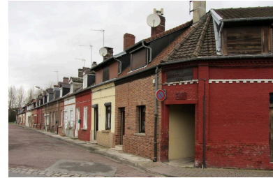
Berteaucourt-les-Dames, cité ouvrière Binet Flandre. Phot. Bertrand Fournier IVR22_20128005319NUC2A
