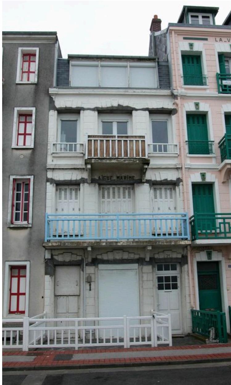
Vue d'ensemble depuis l'esplanade.
