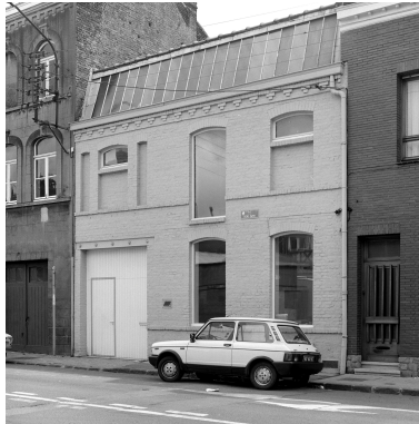
Atelier de fabrication. Élévation rue Denis-Papin. Phot. Philippe Dapvril IVR31_19885901203X
