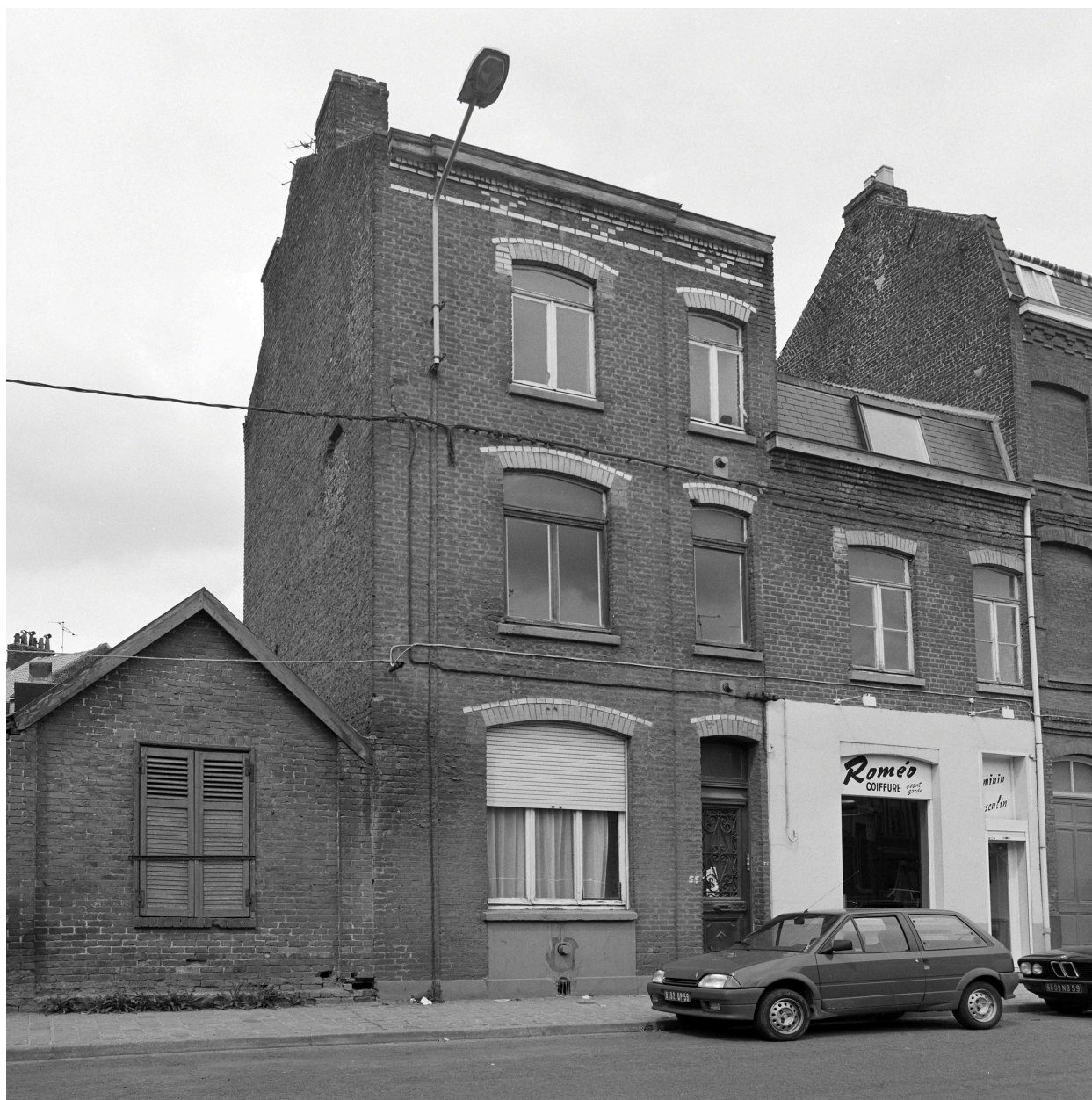
Logement patronal. Élévation rue Nationale.
