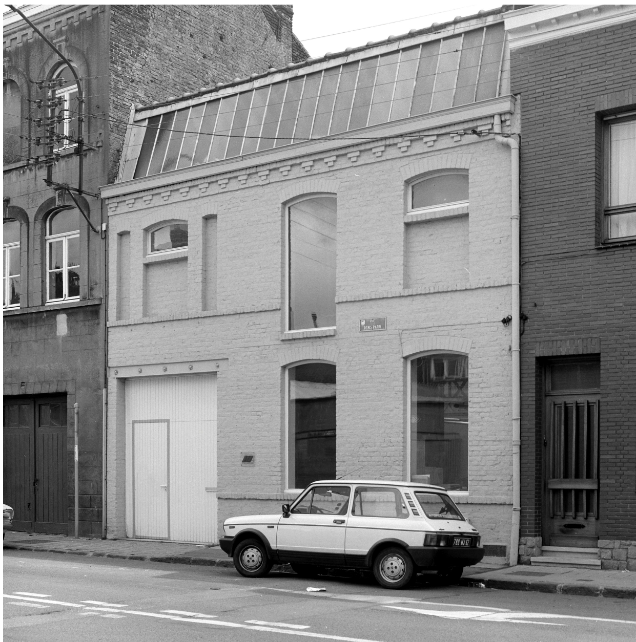
Atelier de fabrication. Élévation rue Denis-Papin.
