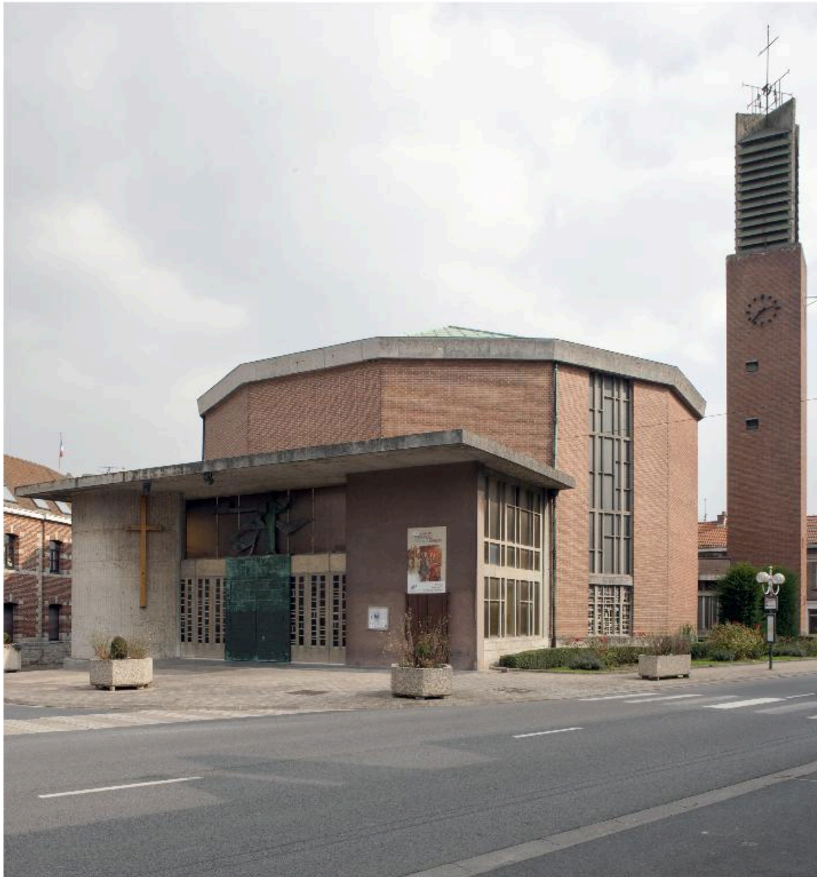
Eglise paroissiale Saint-Quentin de Bouchain (Nord).
