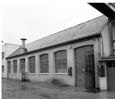
L'atelier de fabrication, fa ade est sur cour. Phot. Thierry Lef bure IVR22_19986000096X
