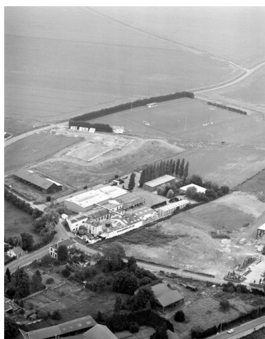
Vue a rienne de l'usine en 1994. Phot. Sanson Aviation IVR22_19946001684X
