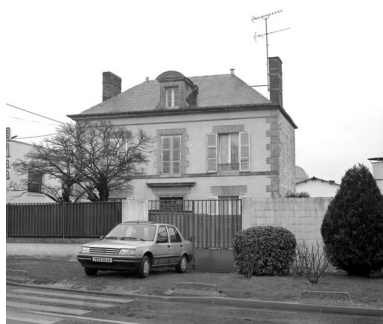
Logement patronal, fa ade sur rue. Phot. Thierry Lef bure IVR22_19986000100X
