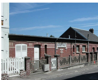
Vue d'ensemble depuis la rue Gros. Phot. Elisabeth Justome IVR22_20048001473NUCA
